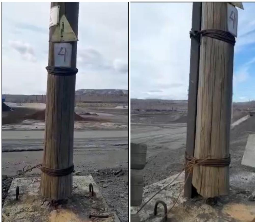
Рисунок 5.1 – Конструкция переносных опор ЛЭП
