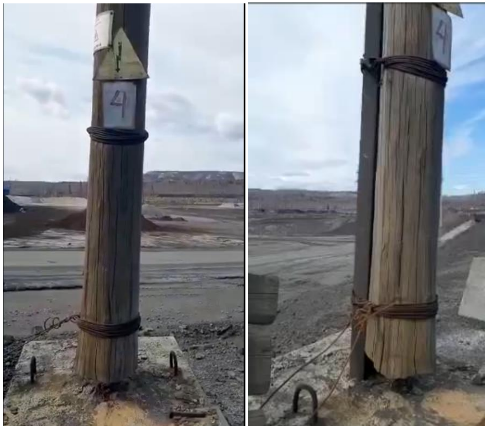
Рисунок 5.1 – Конструкция переносных опор ЛЭП
