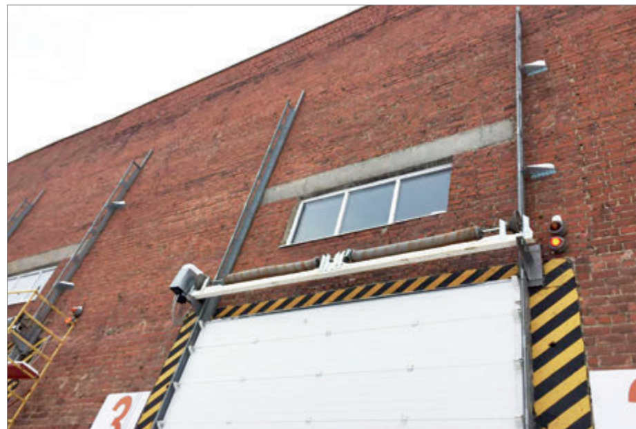
До: приводы ворот, установленные со стороны улицы, подвержены осадкам и как следствие поломкам.
