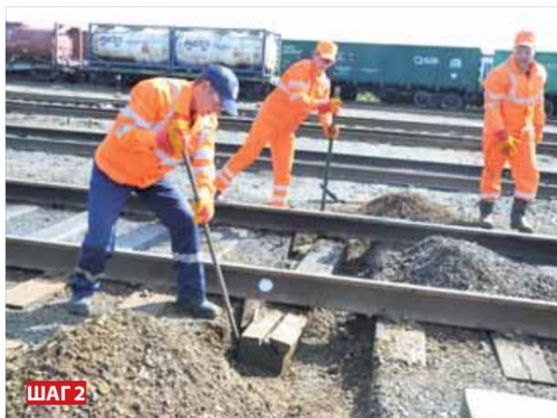
Бригада станции Комбинатская при помощи ломов и клещей сдвигает старую шпалу в «ящик», затем вытягивает из-под рельса. Далее вычищается шпальный ящик, в котором была непригодная шпала, и на ее место заводится новая.
