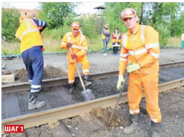
Бригада станции Заводская откапывает шпальный ящик (ямка, куда укладывается шпала). Из непригодной шпалы убирает костыли (большие гвозди для скрепления рельс и шпал) и подкладки (железные пластины между рельсом и шпалой).
