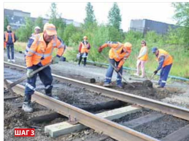
Бригада станций Медная-Новомедная между рельсом и шпалой ставит новые подкладки и «зашивает» (забивает) костыли (сначала основные, а затем обшивочные). Шпальный ящик засыпается балластом и трамбуется.
